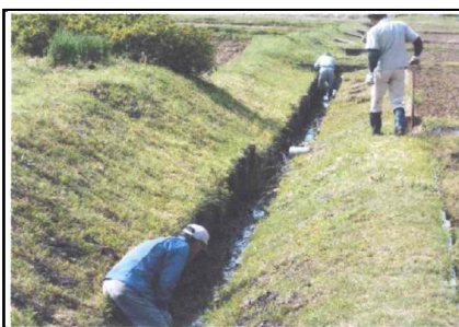
( 用排水路掘りさらい )
